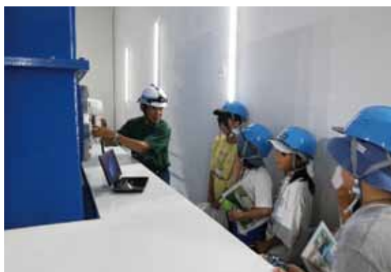
建物内部で発電機の見学
