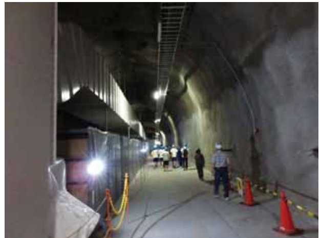
発電機の設置場所に向かいます
